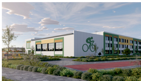
ШКОЛА НА 2000 МЕСТ, ЕСИЛЬСКИЙ РАЙОН ул. ТОЛЕ БИ и Е57А г. АСТАНА Проектирование. Системы контроля и управления доступом Smartec. Системы видеонаблюдения Hikvision. Мониторы в разделе видеонаблюдения Dahua. СКС, пассивная часть Hyperline, ИТК.
