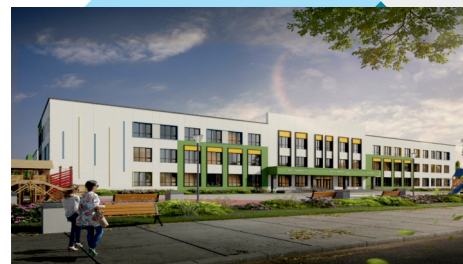
ШКОЛА НА 2000 МЕСТ В ЕСИЛЬСКОМ РАЙОНЕ ЖМ «ТЕЛЬМАН» г. АСТАНА Щитовое оборудование Chint, ЗУИ ЕКФ, Shelbi. Лотки от Bylectrica, ELPA. Раздел МГН Тромбон. СКС, пассивная часть ИЕК/ИТК.
