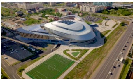
ДВОРЕЦ ЕДИНОБОРСТВ, г. АСТАНА Проектирование. Щитовое оборудование Legrand.
