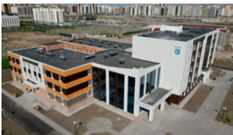
ШКОЛА «NEOTECH DIGITAL SCHOOL», г. АСТАНА Поставка: щитовое оборудование ЕКФ, электроустановочные изделия Legrand, освещение Philips. Электромонтажные работы по внутреннему электроснабжению.
