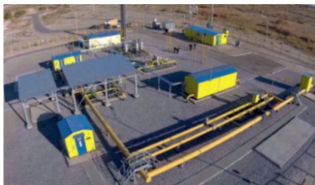
АВТОМАТИЧЕСКАЯ ГАЗОРАСПРЕДЕЛИТЕЛЬНАЯ СТАНЦИЯ 1, г. АСТАНА Ремонт и монтаж наружных сетей электроснабжения 0,4 кВ.
