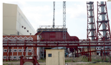
ТЭЦ-3, г. АСТАНА Электромонтажные работы по внутреннему электроснабжению, КИПиА.
