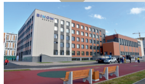
ШКОЛА «VINOM», CAPITAL PARK, г. АСТАНА Проектирование. Поставка: щитовое оборудование ИЕК, электроустановочное оборудование Legrand, лотки ДКС, освещение Световые Технологии.
